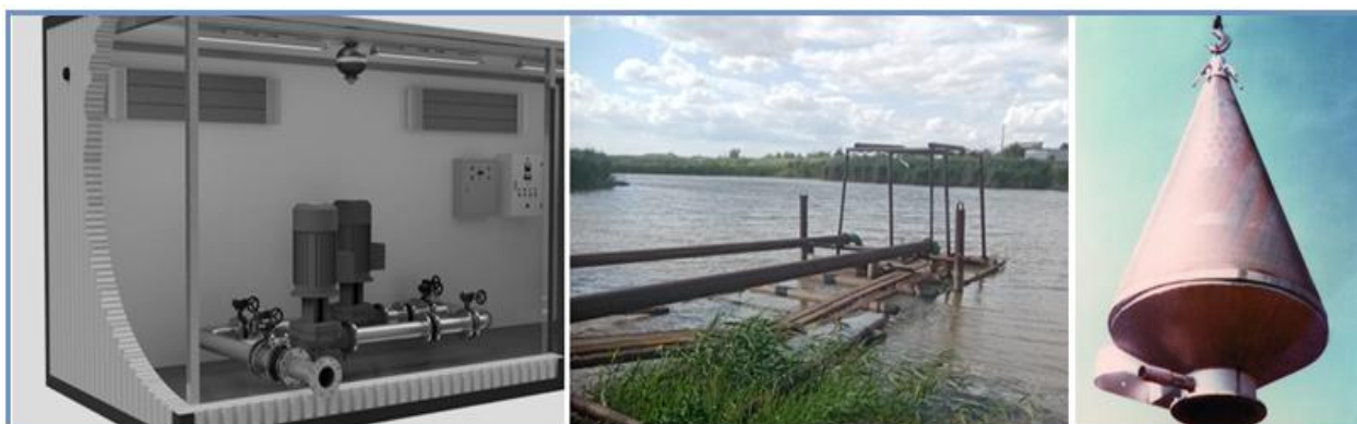
Рисунок 1. Блочно-модульная насосная станция с РОПом, Быковский район, Волгоградская область
