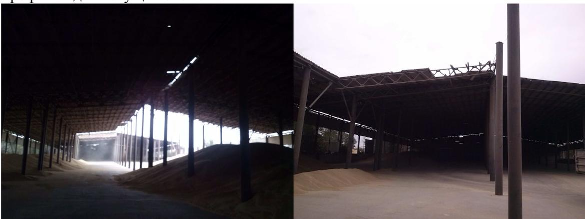
Рисунок 7 – Разрушенные части перекрытий зернохранилища
